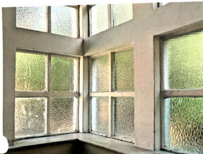
Escada, lado de dentro
