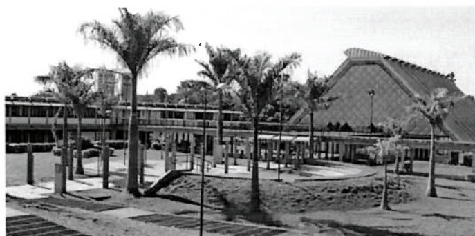
Figura 4 Edifício do Ciaç Fonte: UEM (2011).
