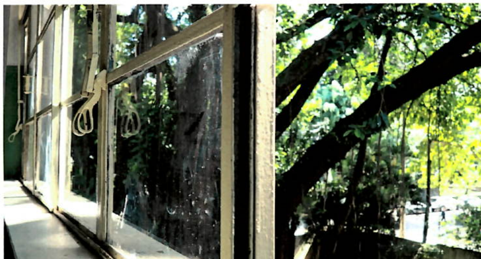
Sala de aula, piso superior
