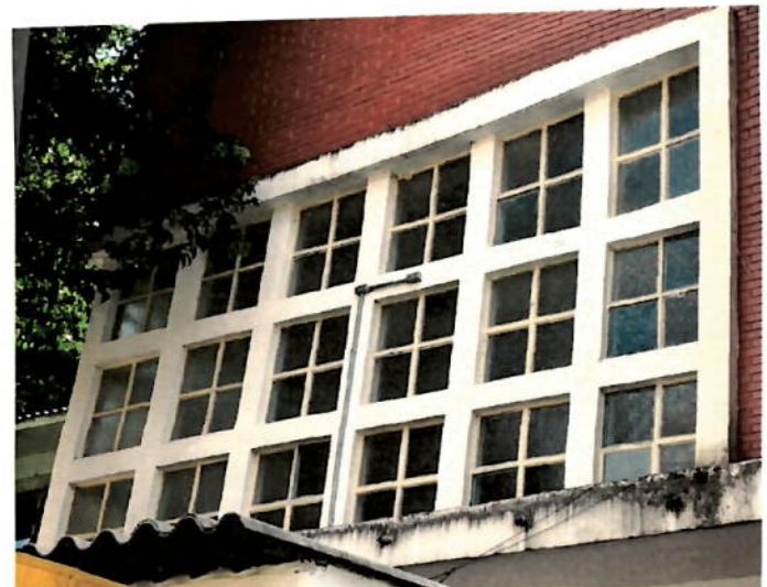
Escada, lado de fora
