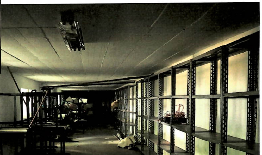
Porão, detalhe janela/abertura de ventilação
