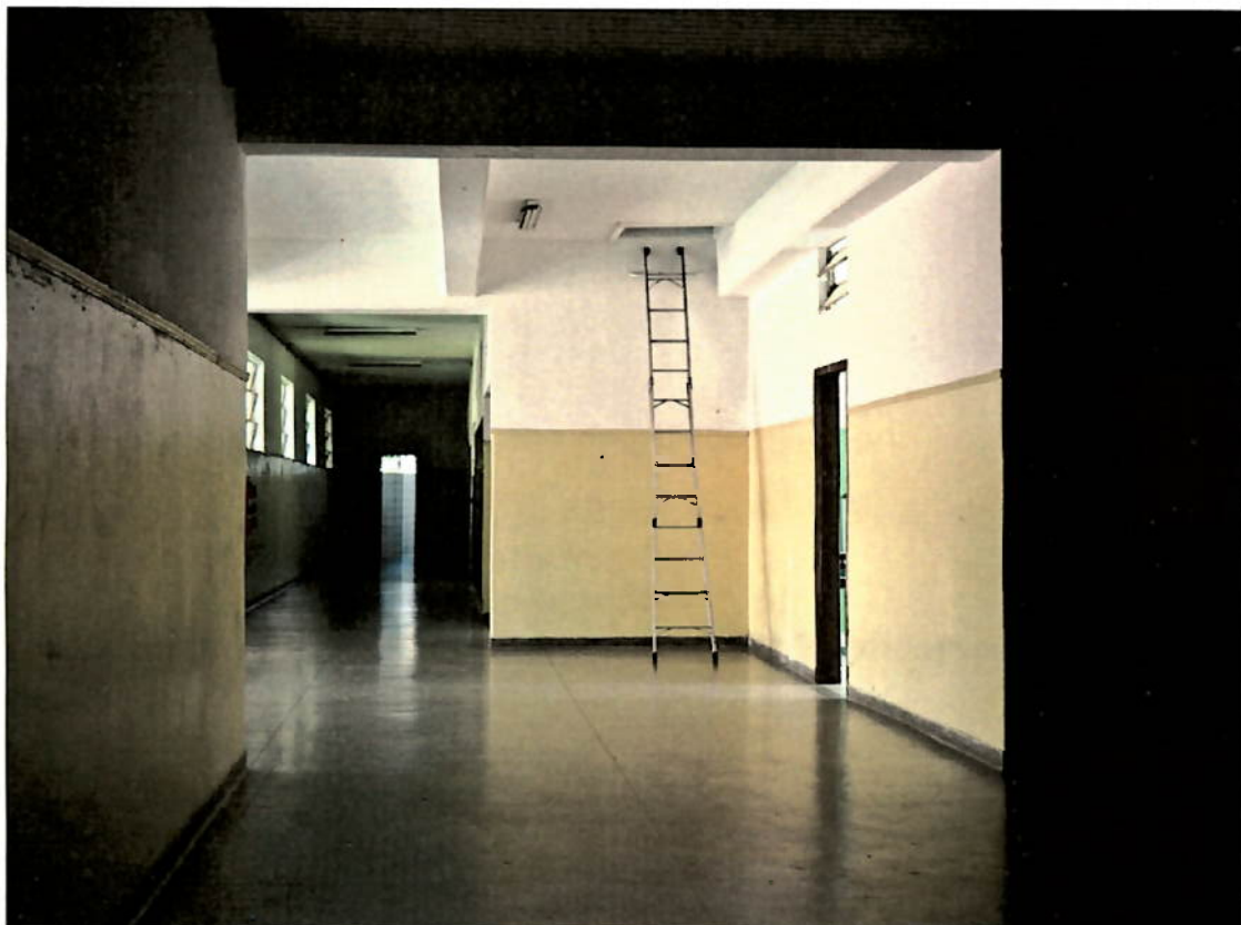
Corredor 1º piso
