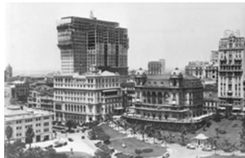
FIGURA 5 (Edifício Martinelli em construção): À esquerda, Edifício Martinelli, em construção; à direita Edifício Sampaio Moreira. Vale do Anhangabaú, São Paulo, 1927 [SAN/DIM/DPH/SMC/PMSP]
