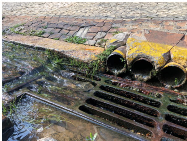
FIGURA 5.4 Fotos do afloramento de água junto da Pç. Arquimedes da Silva e do córrego Caaguaçu visto por entre a grelha, na R. Dr. Astolfo Araújo
