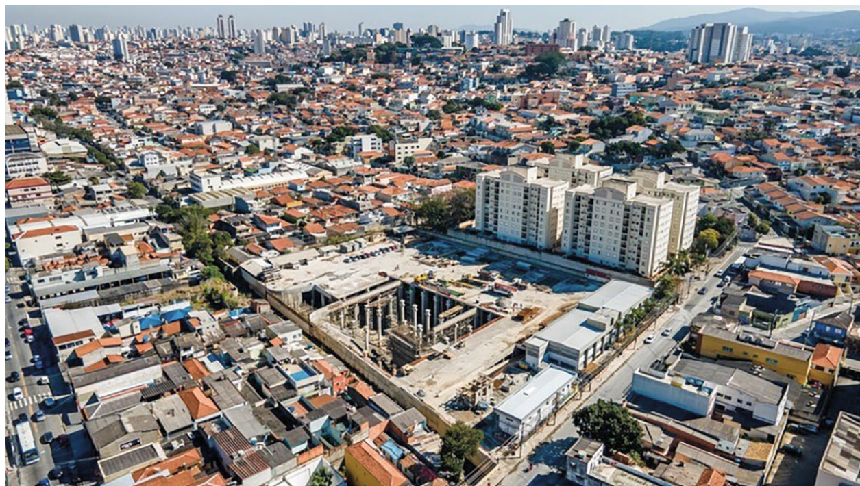
FIGURA 2.3 Foto aérea do reservatório RPA-1 durante sua construção (foto: Edson Lopes Jr./Secom)
