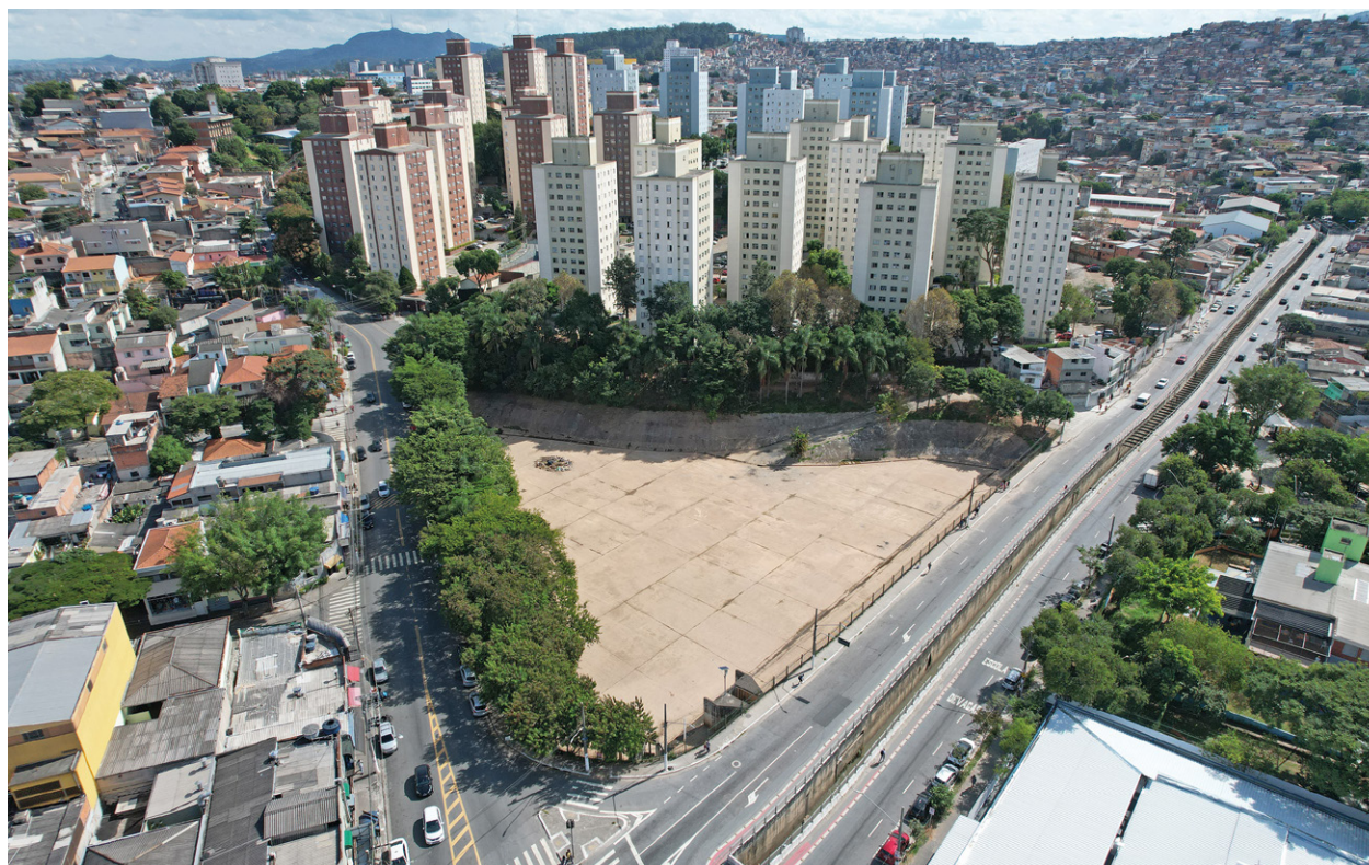
FIGURA 2.8 Reservatório Rio das Pedras (RPD-1)
