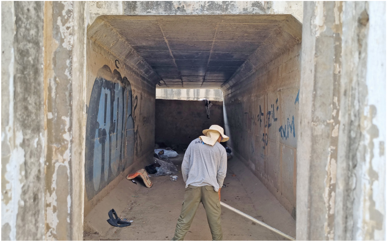
FIGURA 2.9 Estrutura de entrada do reservatório Rio das Pedras
