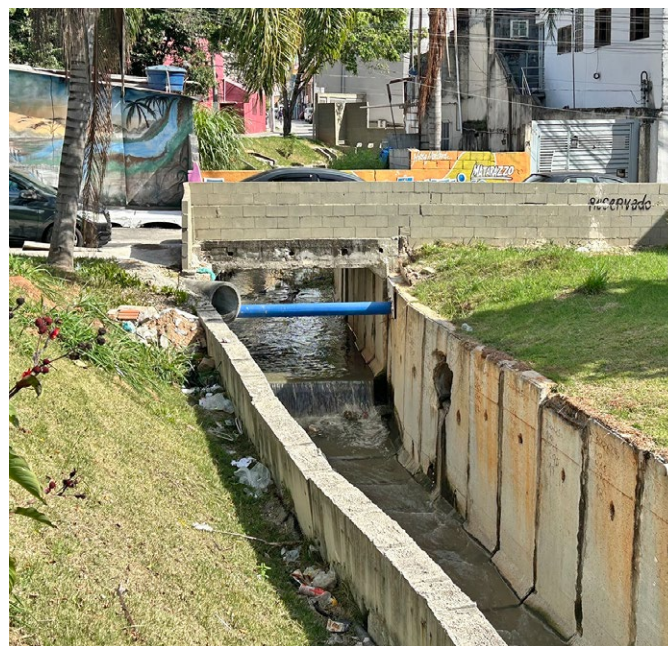
Último trecho do córrego Boturussu, canalizado em concreto e com uma tubulação azul característica de interferência da SABESP (foto: Afonso Virgiliis, 2025)
