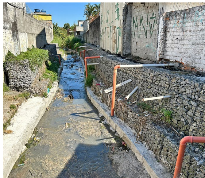
Ligações atípicas de esgoto realizadas pela SABESP (foto: Afonso Virgiliis, 2025)
