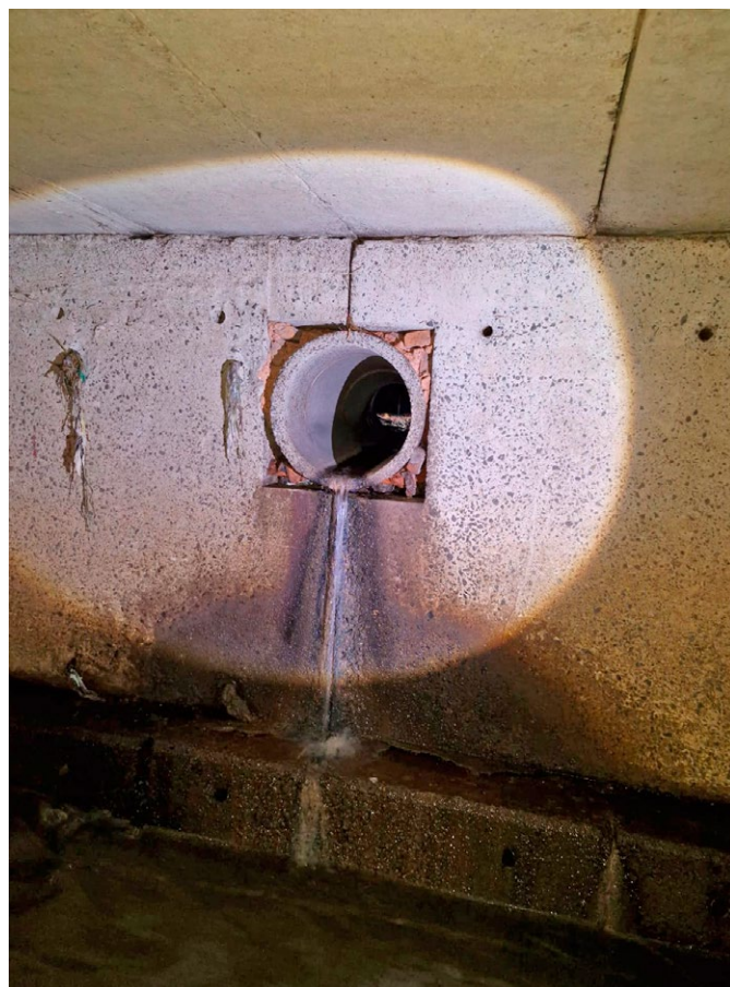
Ligações de microdrenagem a 90° (foto: Afonso Virgiliis, 2025)
