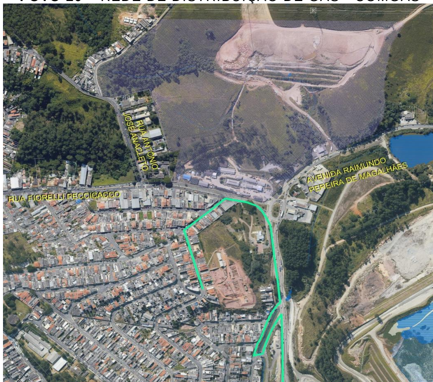
FOTO 20 – REDE DE DISTRIBUIÇÃO DE GÁS - COMGÁS
