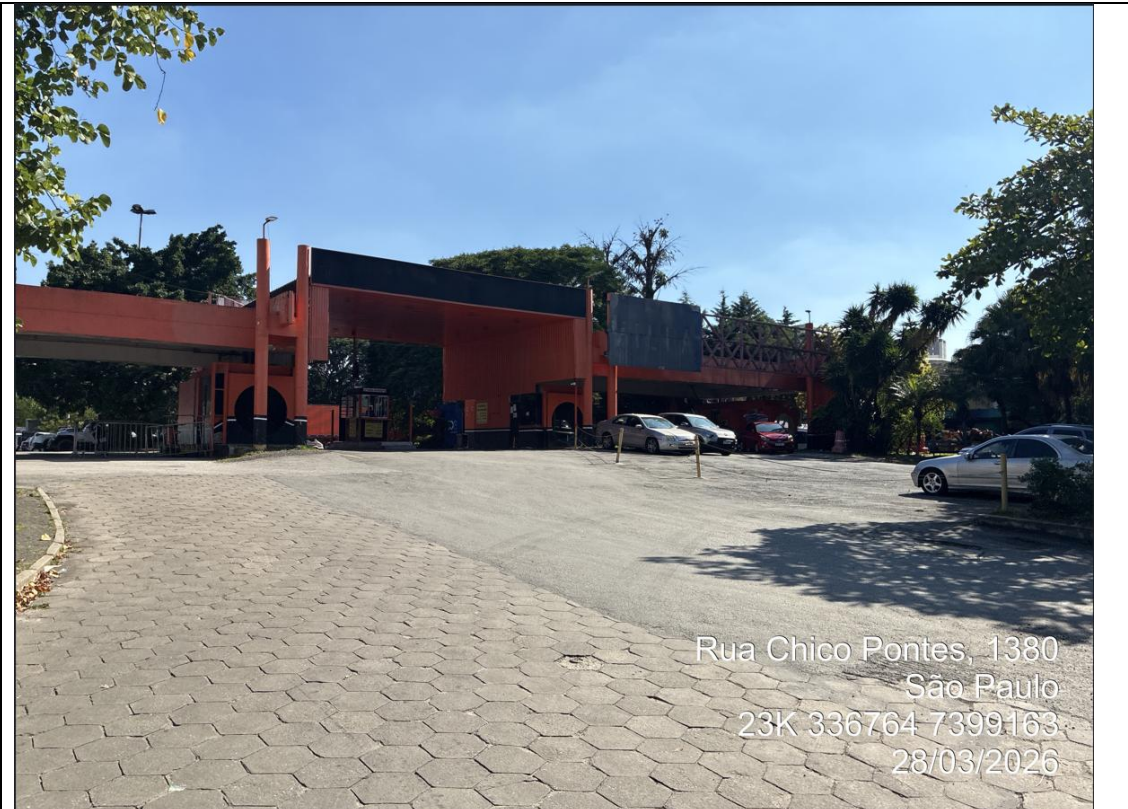
Foto 3.5-7: Acesso principal ao futuro Centro Logístico Chico Pontes, evidenciando a área de entrada e controle de veículos na Rua Chico Pontes.
