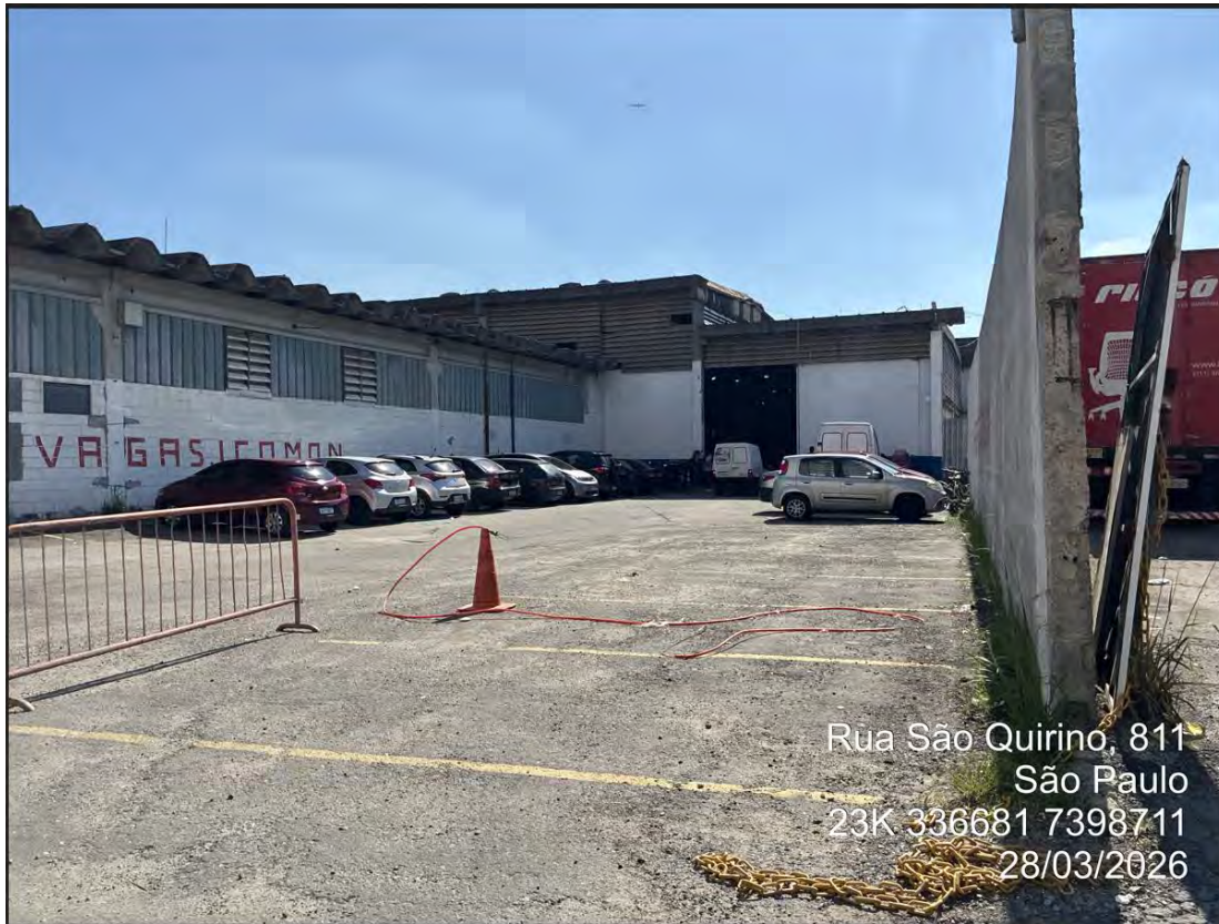
Foto 3.4-29: Pátio de galpão logístico com estacionamento de veículos e área operacional pavimentada.
