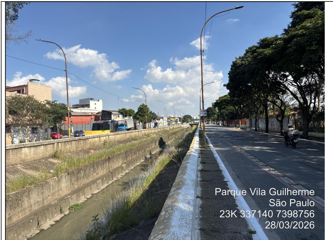
Foto 3.5-10 Trecho do canal de drenagem canalizado paralelo ao sistema viário na Vila Guilherme, evidenciando a interface entre infraestrutura hidráulica e mobilidade urbana na AID do empreendimento.
