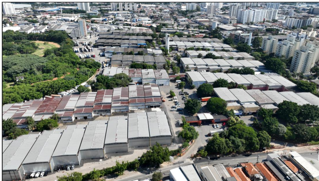
Foto 3.5-16- Vista aérea da Área Diretamente Afetada na Vila Guilherme, evidenciando a predominância de galpões logísticos e industriais, pátios operacionais e áreas de estacionamento de veículos, em contexto urbano altamente antropizado e com elevada taxa de impermeabilização do solo.
