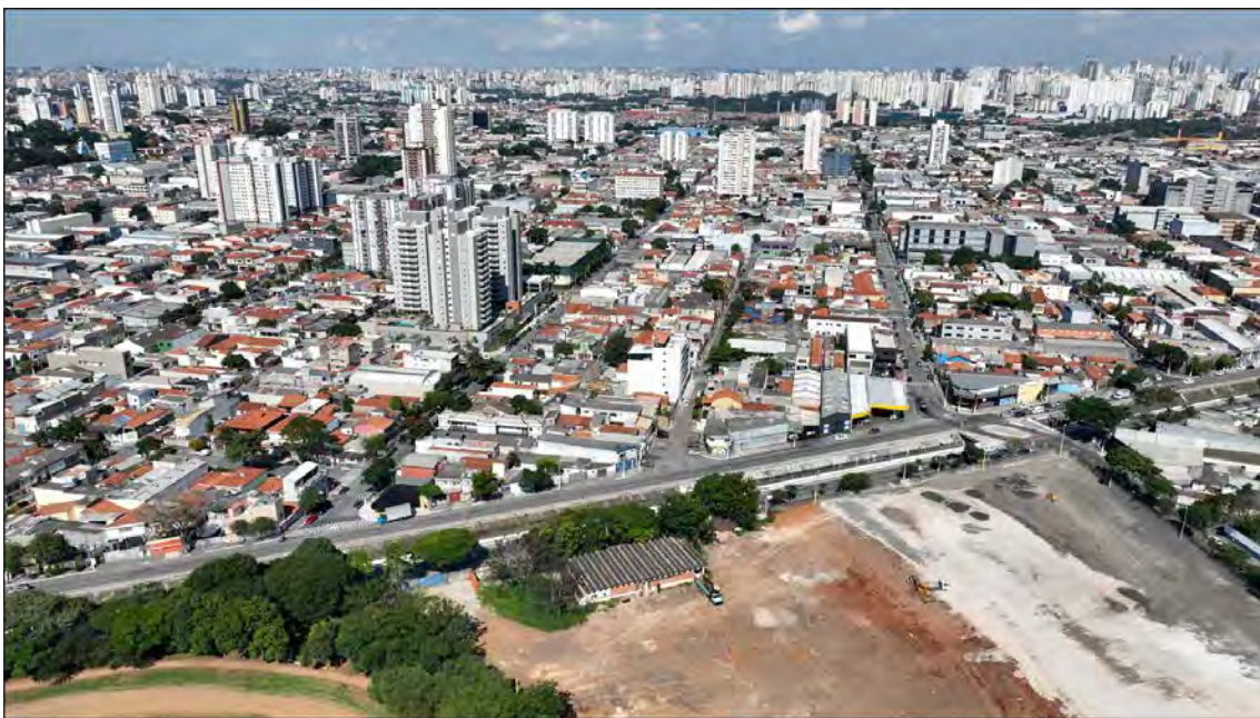
Foto 3.2-3: Vista aérea da área de influência direta do empreendimento
