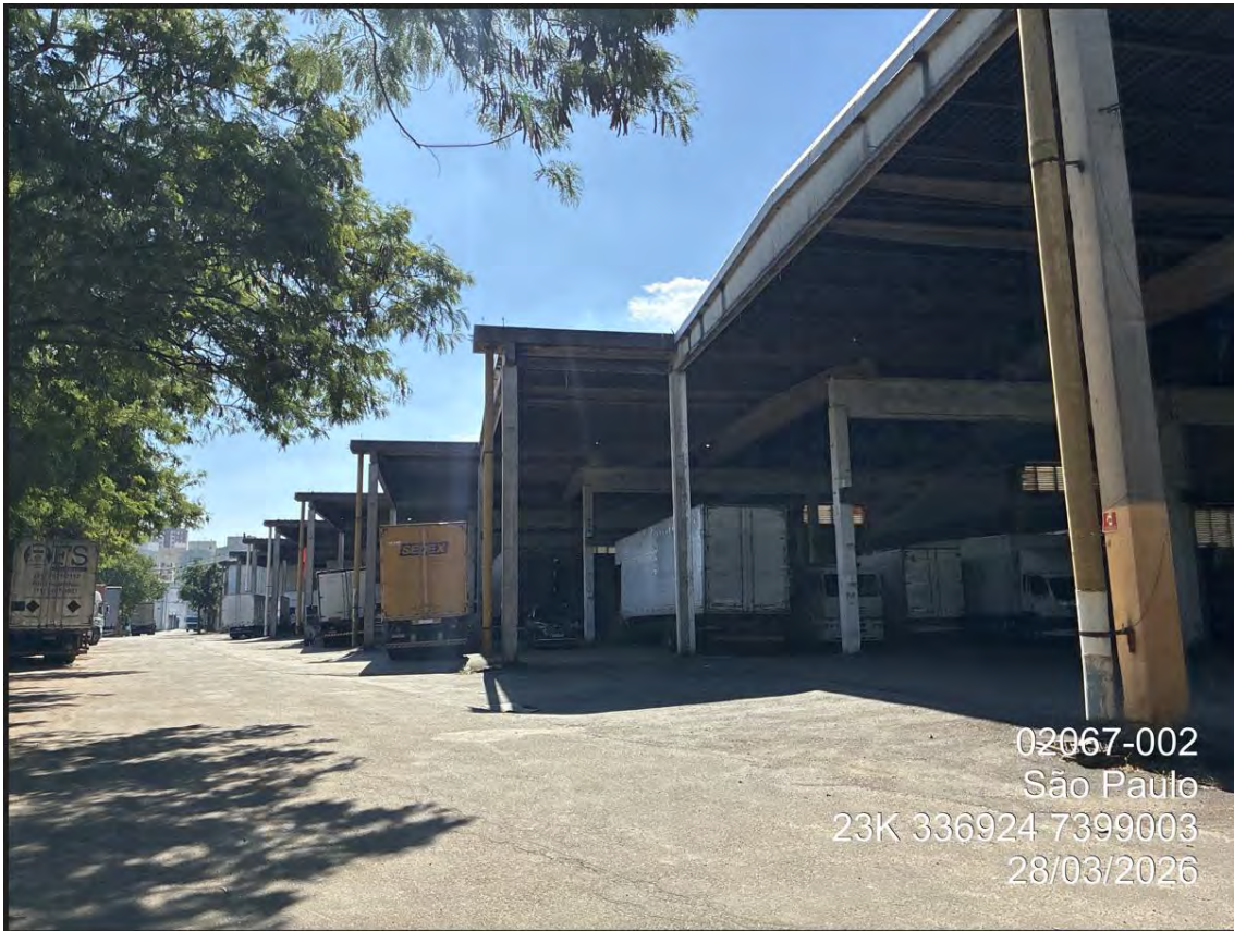
Foto 3.4-25: Docas de carga e descarga com operação de caminhões e pátio pavimentado.
