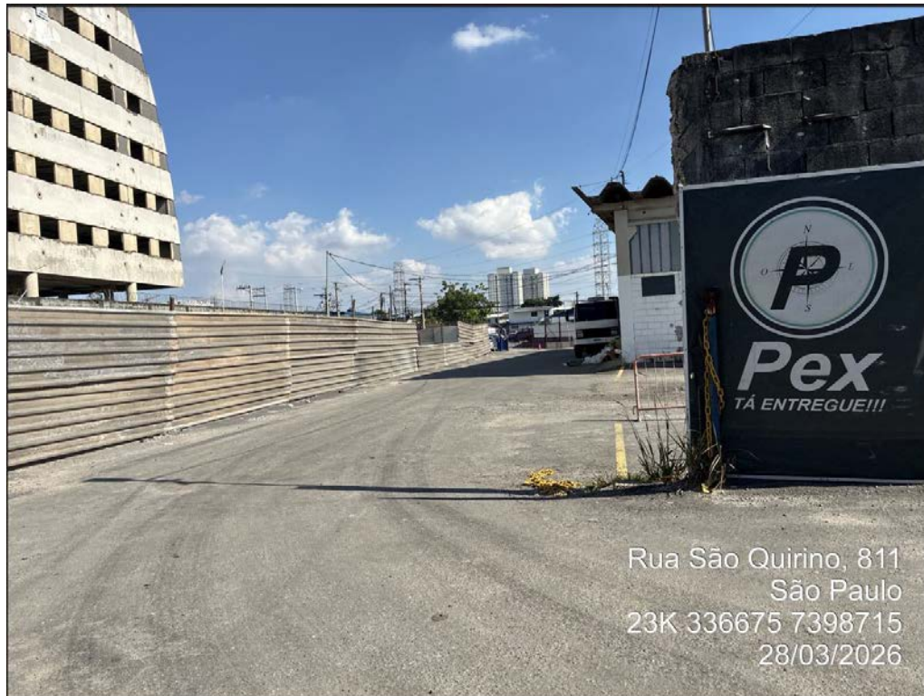
Foto 3.5-25: Acesso a pátio logístico com via interna pavimentada e controle de entrada de veículos.
