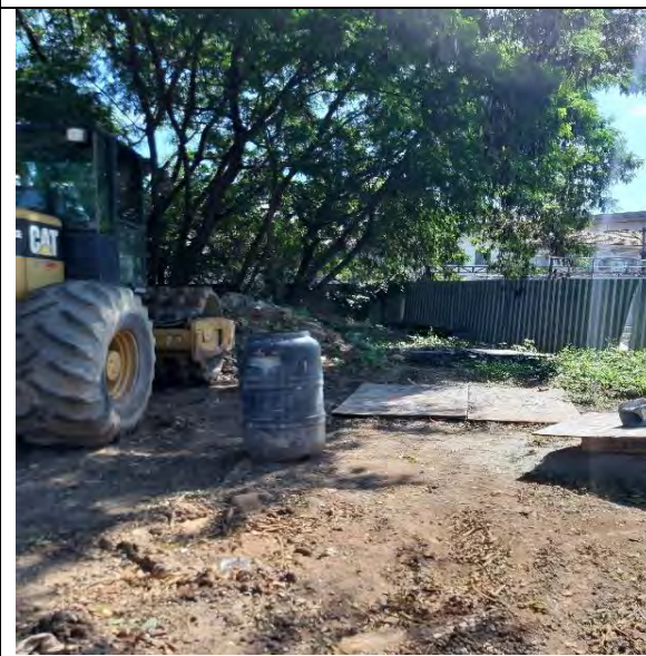
Foto 3.3-34: Tambor abandonado com acúmulo de água de chuvas.
