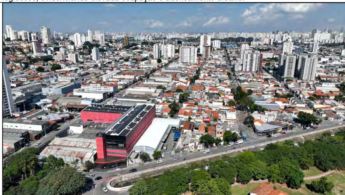
Foto 3.4-4: Vista aérea da AID na Vila Guilherme, com destaque para a Avenida Nadir Dias de Figueiredo, estruturando o sistema viário local, e para o corpo d'água canalizado adjacente, evidenciando a intensa antropização e a elevada impermeabilização do território.
