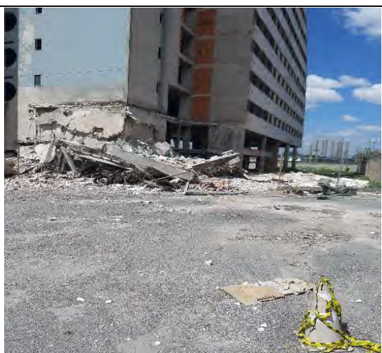
Foto 3.3-31: Área do Prédio em demolição.
