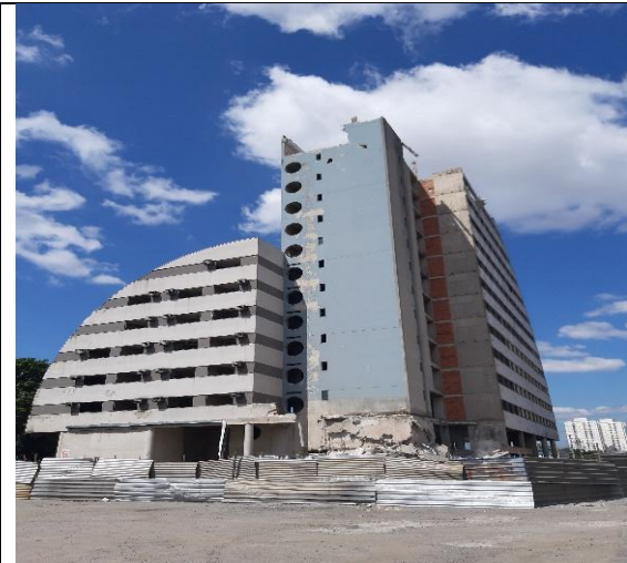
Foto 3.4.2-30: Prédio em demolição.
