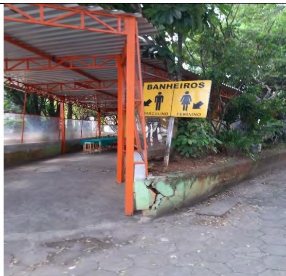
Foto 3.3-29: Área de apoio. Banheiros e área para alimentação.
