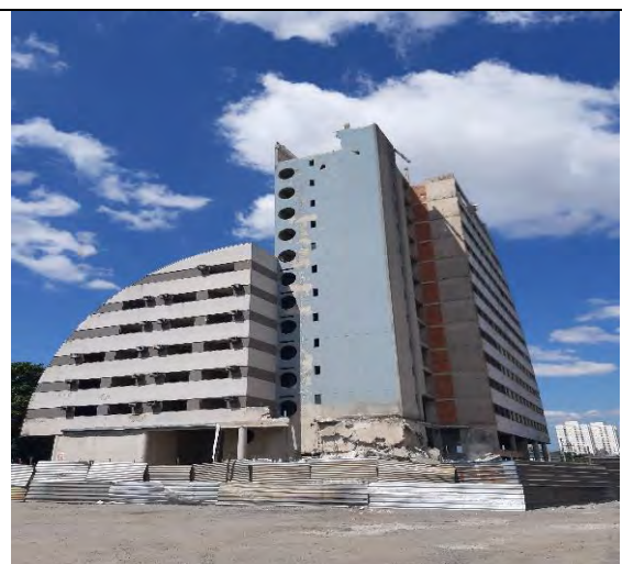
Foto 3.3-30: Prédio em demolição.
