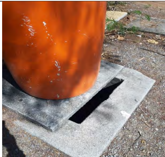
Foto 3.3-63: Caixa de inspeção mal tampada servido de acesso a animais sinantropicos oportunistas.
