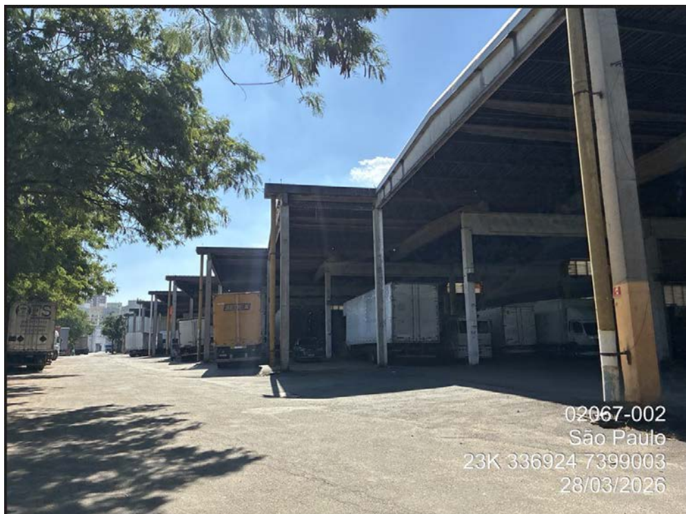
Foto 3.5-22: Docas de carga e descarga com operação de caminhões e pátio pavimentado.
