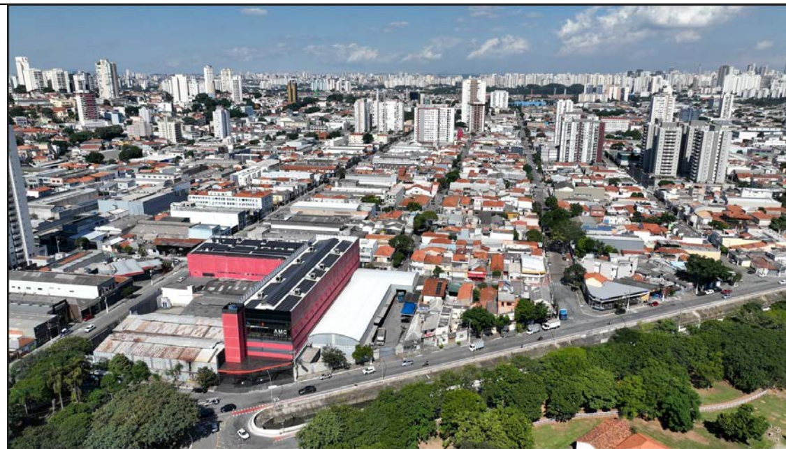
Foto 3.5-4: Vista aérea da AID na Vila Guilherme, com destaque para a Avenida Nadir Dias de Figueiredo, estruturando o sistema viário local, e para o corpo d'água canalizado adjacente, evidenciando a intensa antropização e a elevada impermeabilização do território.
