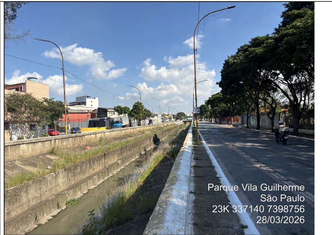
Foto 3.4-10 Trecho do canal de drenagem canalizado paralelo ao sistema viário na Vila Guilherme, evidenciando a interface entre infraestrutura hidráulica e mobilidade urbana na AID do empreendimento.
