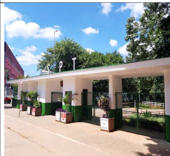
Foto 3.3-70: Vistoria no Parque do Trote (área vizinha)
