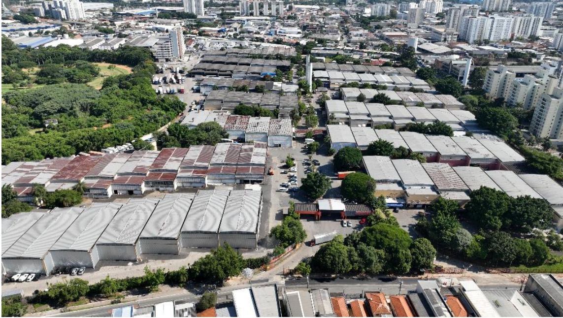
Foto 3.3-3 - A vista aérea da área diretamente afetada evidencia o uso e instalações de galpões para usos diversos (marcenarias, comércios, escritórios, pátio de ônibus e caminhões, entre outros)
