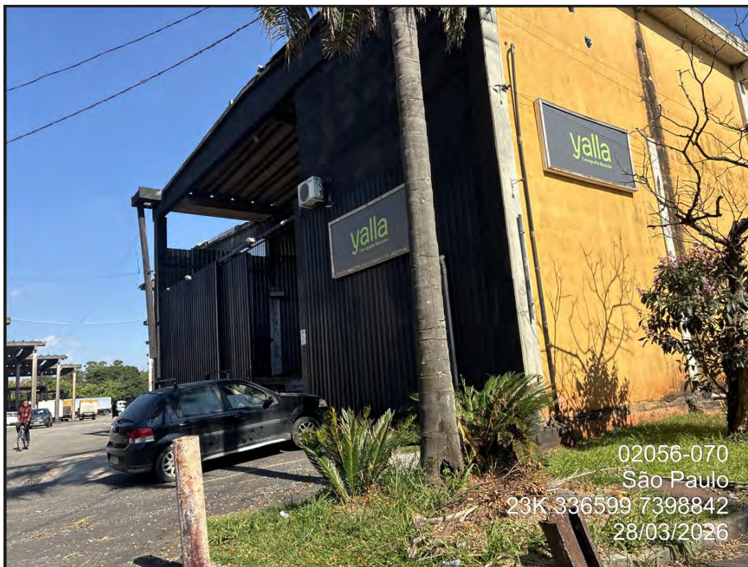
Foto 3.4-30: Fachada de galpão logístico com acesso operacional e estacionamento de veículos.
