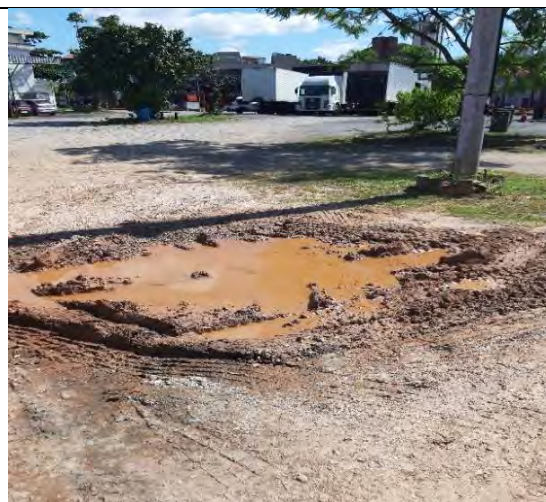
Foto 3.3-54: Acumulo de água de chuvas em depressões no solo.
