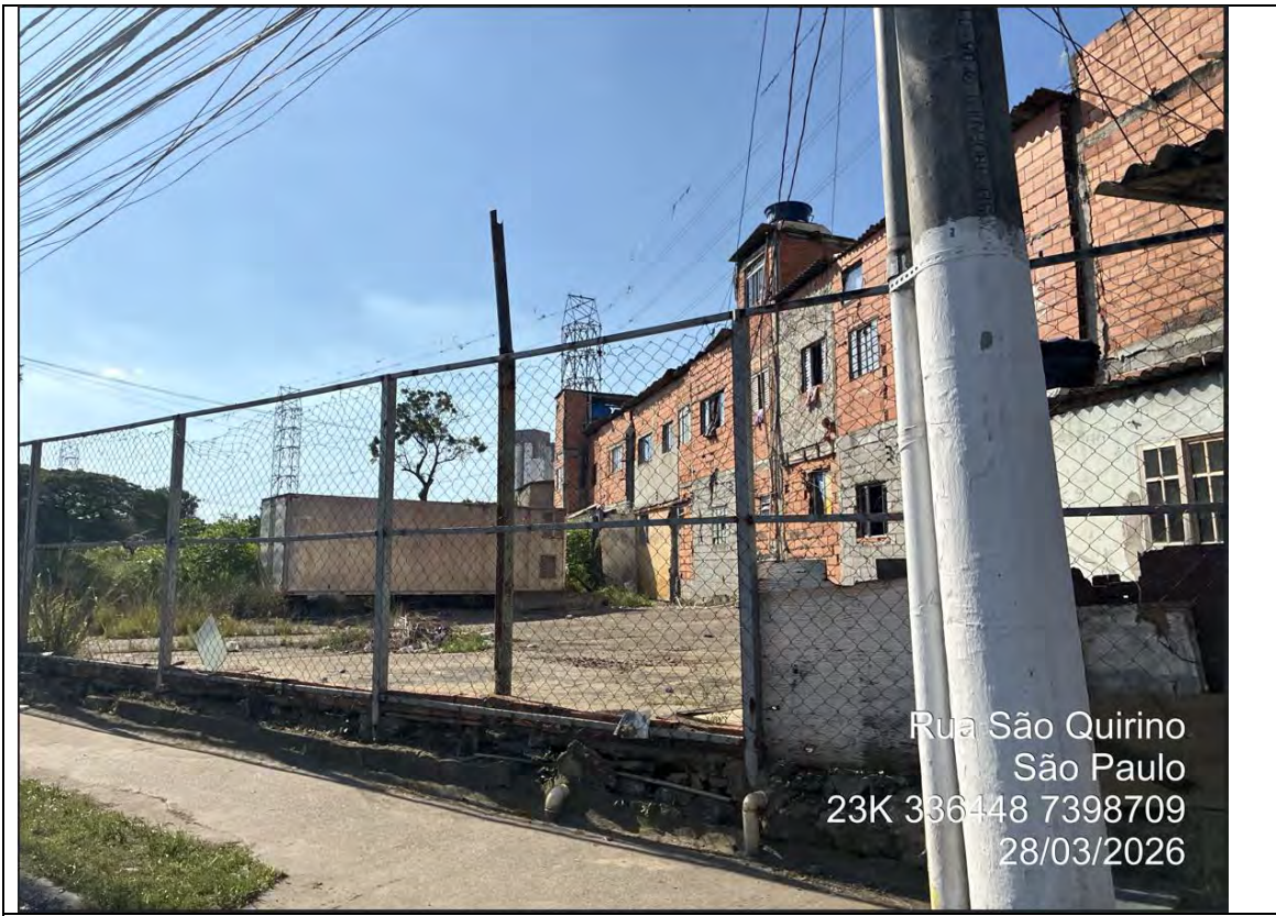
Foto 3.4-12: Trecho da AID evidenciando ocupação informal de baixa renda, com moradias autoconstruídas e padrão construtivo precário, indicando a presença de assentamentos subnormais no entorno do empreendimento.
