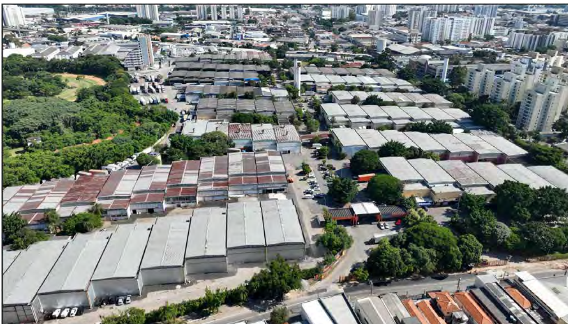
Foto 3.4-19- Vista aérea da Área Diretamente Afetada na Vila Guilherme, evidenciando a predominância de galpões logísticos e industriais, pátios operacionais e áreas de estacionamento de veículos, em contexto urbano altamente antropizado e com elevada taxa de impermeabilização do solo.
