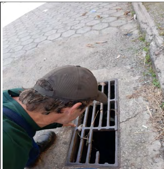
Foto 3.3-44: Vistoria em bueiros.
