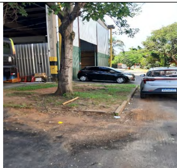
Foto 3.3-28: Áreas dos galpões em boas condições.
