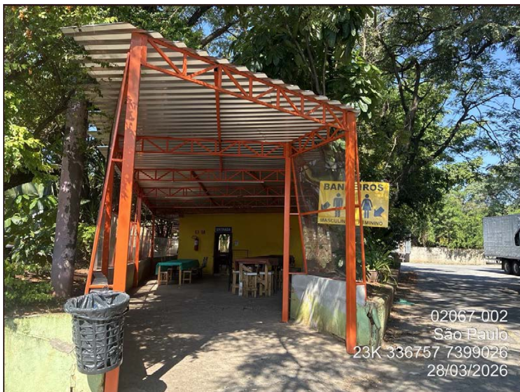
Foto 3.5-20 – Estrutura de apoio aos trabalhadores, com área de convivência e sanitários
