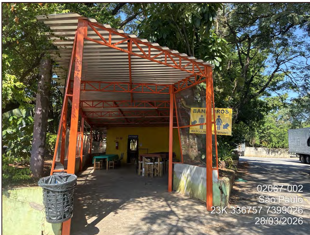
Foto 3.4-23 – Estrutura de apoio aos trabalhadores, com área de convivência e sanitários
