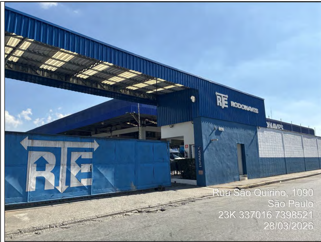
Foto 3.4-11 Instalação logística na Rua São Quirino, demonstrando uso industrial/comercial predominante na AID do empreendimento.
