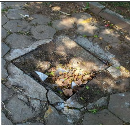
Foto 3.3-64: Caixa de inspeção mal tampada em más condições de conservação e manutenção.
