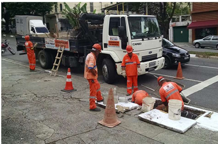
Legenda: Exemplo de Serviço de Drenagem
